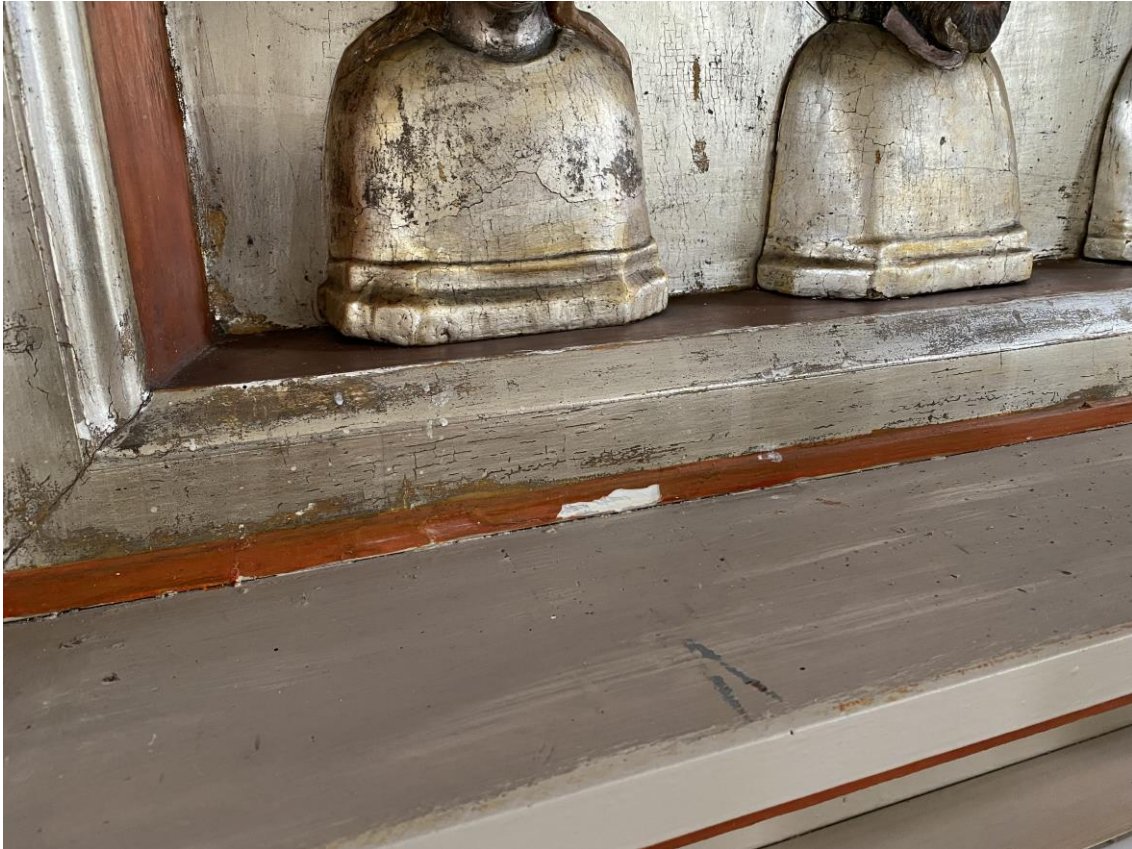
Fot. 6. Fragment obiektu -widoczne zniszczenia na srebrzeniach
