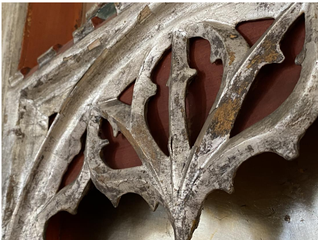
Fot 18. Widoczne ubytki i zniszczenia srebrzeń
